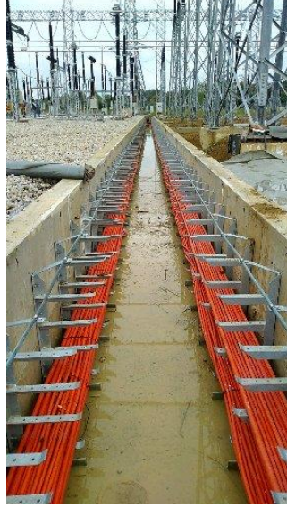
Şekil 29 : Çelik Konstrüksiyon ve Betonarme Kanal
