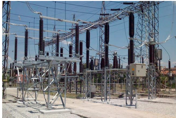
Şekil 40 : Kesici ve Ayırıcı
