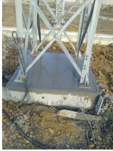
Şekil 32 : Direk Topraklaması
