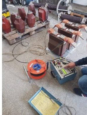
Şekil 39 : Akım Trafosu Polarite Testi
