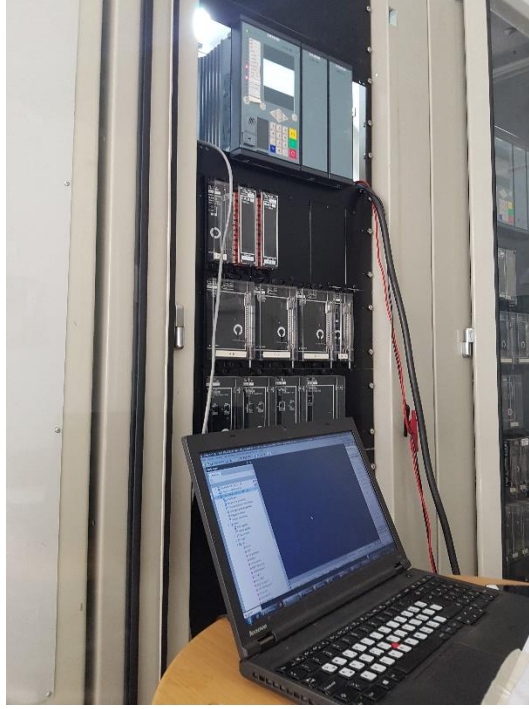
Şekil 18: Mesafe Koruma Rölesi Testi
