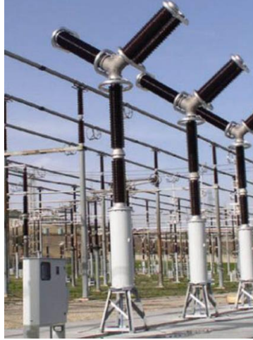
Şekil 7 : 380 kV Kesicisi
