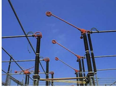
Şekil 8 : 380kV Ayırıcısı
