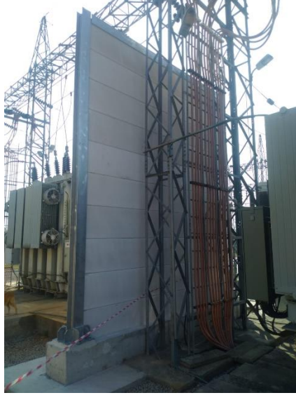
Şekil 34 : Trafo Temeli ve Kablo Kanalı
