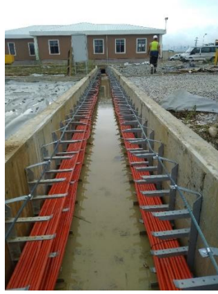
Şekil 33 : Kumanda Binası ve Betonarme Kanal
