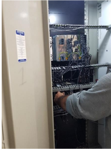
Şekil 17: Röle Panosunda Röle Bağlantılarının Yapılması
