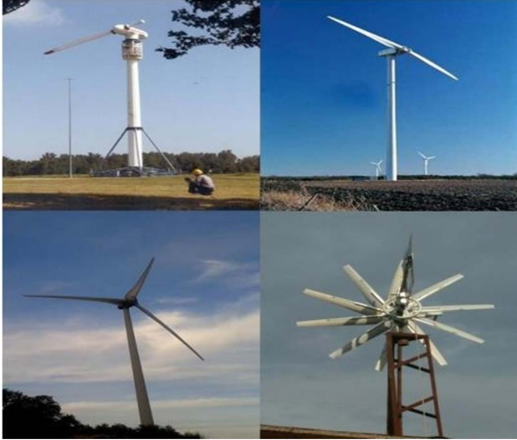
Şekil 19. Rüzgârı Önden ve Arkadan Alan Yatay Eksenli Türbin Tasarımları
